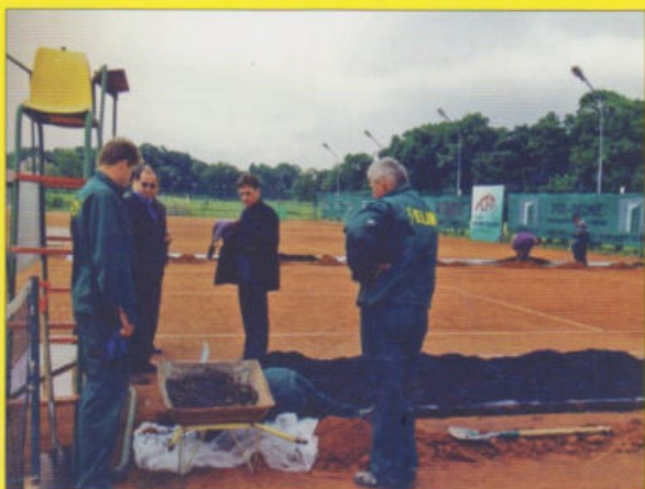
Prace przy budowie instalacji doświetlającej korty
